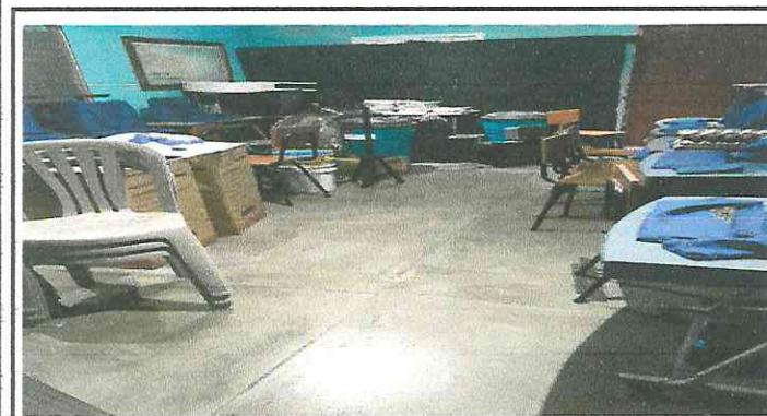
Foto 3: Vista de piso de concreto a reemplazar en el laboratorio de Computación.
