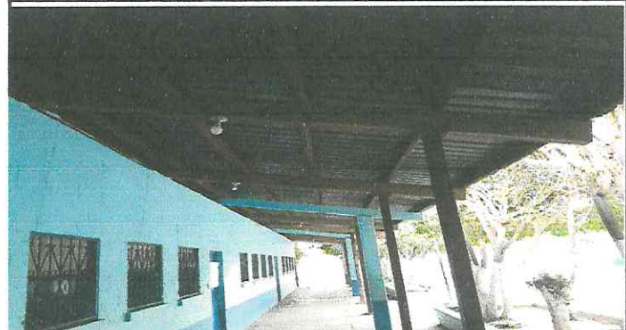
Foto 2: Vista interna de los módulos a intervenir.
