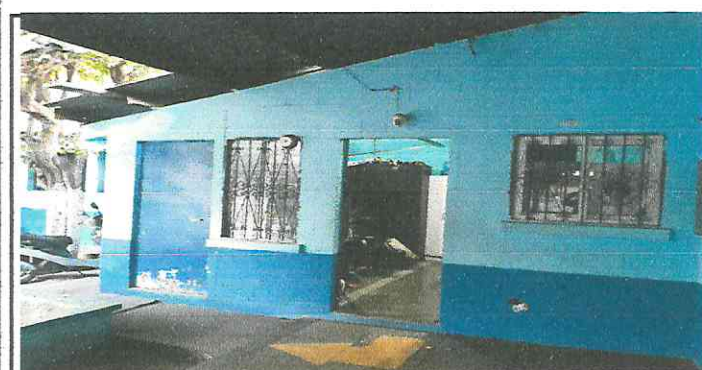
Foto 5: Vista de frontal de dirección, área que se cerrara y se reemplazará y se instalará ventana.
